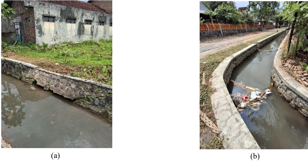
Gambar 4. (a) Kerusakan saluran sekunder Kregan (b) Terdapat sampah di saluran sekunder Kregan.
