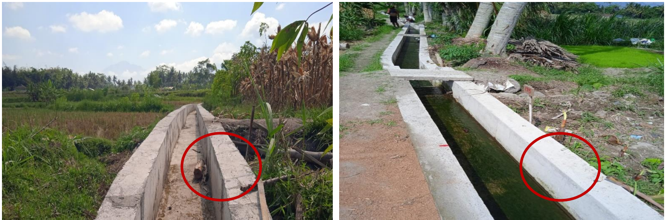
a) Hasil Akhir Pekerjaan Saluran Lokasi I
