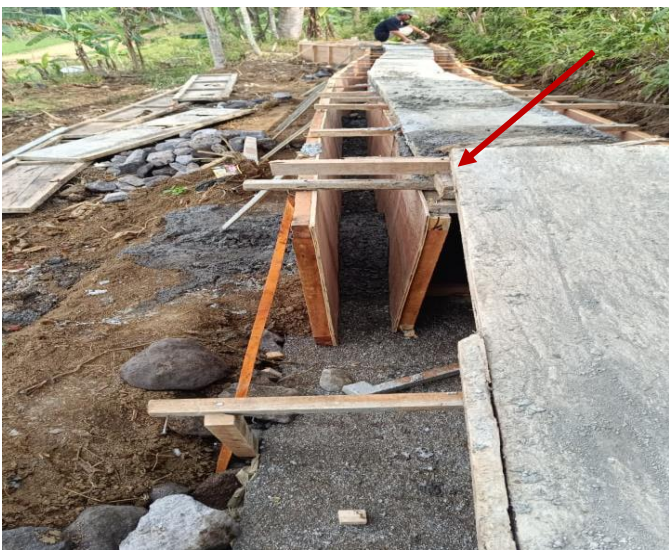
a) Pekerjaan bekisting Lokasi I
