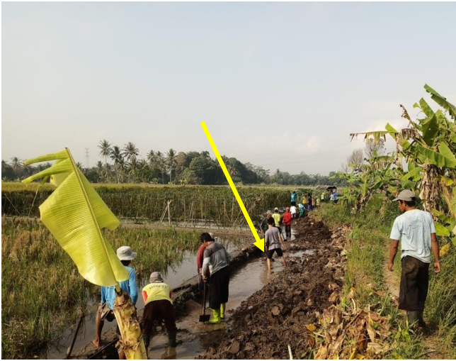
A. Pelaksanaan pekerjaan Lokasi I
