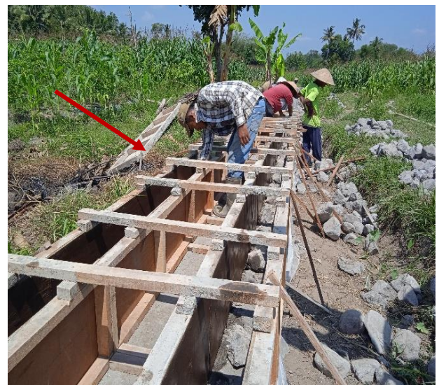
b) Pekerjaan bekisting Lokasi II
