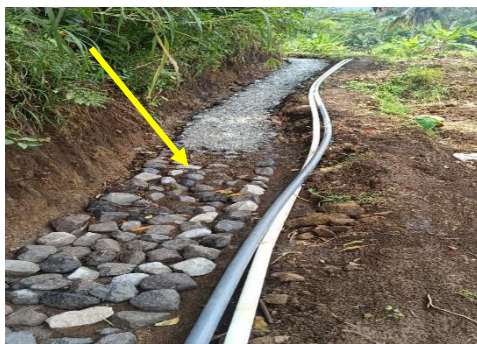
c) Pelaksanaan beton siklop pada Lokasi I
