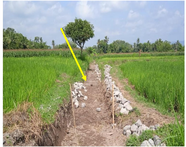
B. Pekerjaan awal Lokasi II
