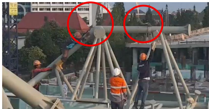
Gambar 4. Pemasangan slings
