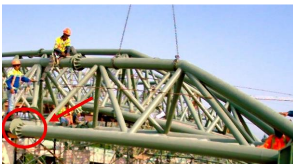
Gambar 6. Terjadi penyimpangan geometri
