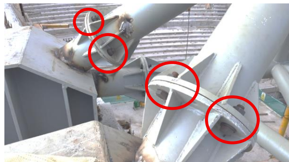
Gambar 9. Kondisi akhir pemasangan baut
