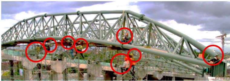
Gambar 14. Pengerahan tenaga kerja untuk reposisi rafter
