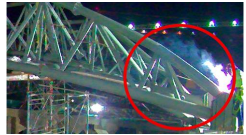
Gambar 15. Pengelasan pada box plate
