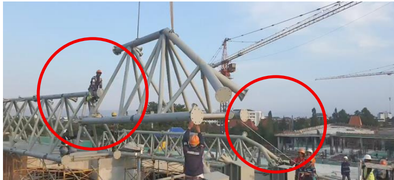
Gambar 5. Pengangkatan menuju modul acuan terpasang
