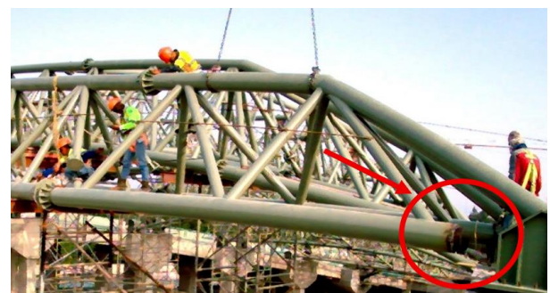
Gambar 7. Pemotongan pipa pada akhir pemasangan rafter
