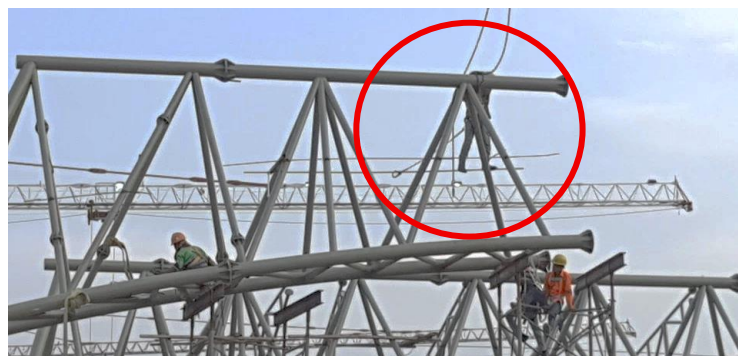
Gambar 10. Kondisi sling telah dilepas dan modul sudah terpasang
