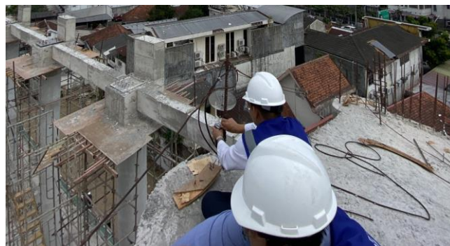
Gambar 1. Pemasangan kamera Time lapse
