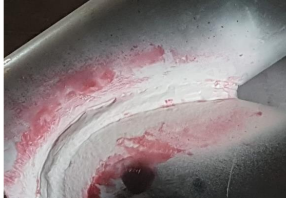
Gambar 8. Uji penetrant pada modul yang telah dilakukan pengelasan
