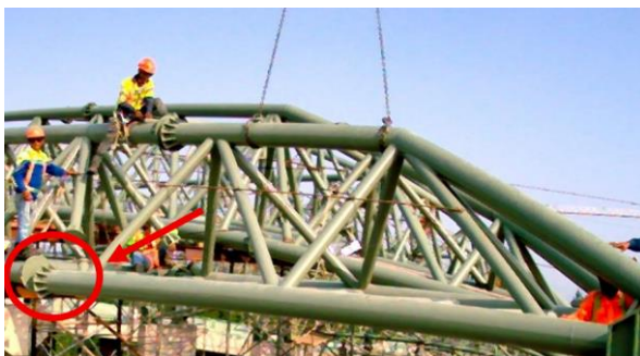
Gambar 6. Terjadi penyimpangan geometri
