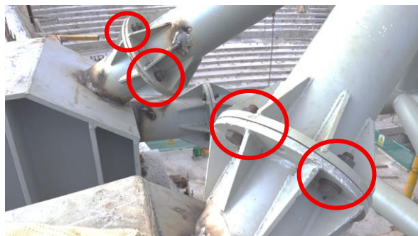
Gambar 9. Kondisi akhir pemasangan baut
