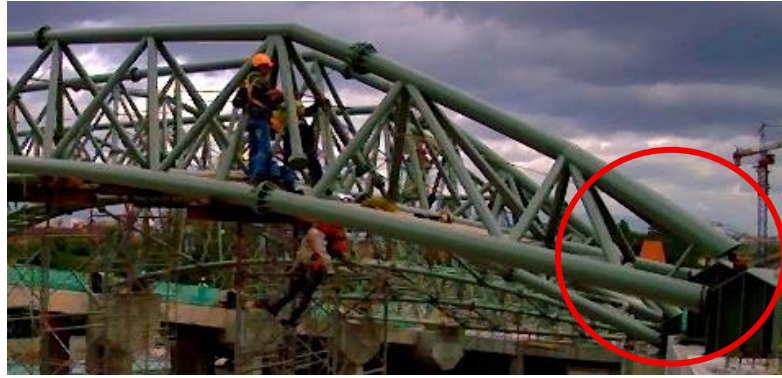
Gambar 13. Pemotongan pada Modul 7
