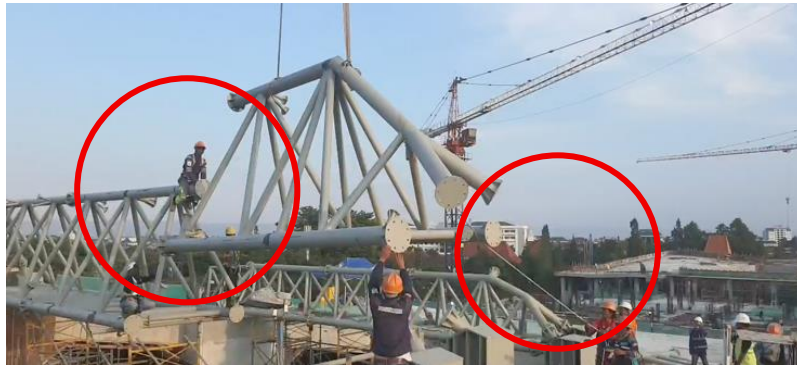
Gambar 5. Pengangkatan menuju modul acuan terpasang
