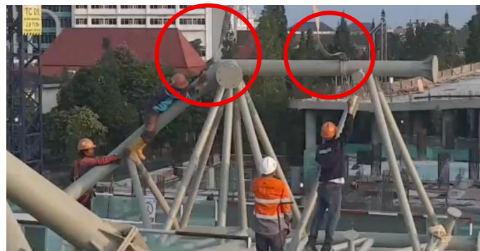
Gambar 4. Pemasangan sling
