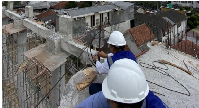
Gambar 1. Pemasangan kamera Time lapse
