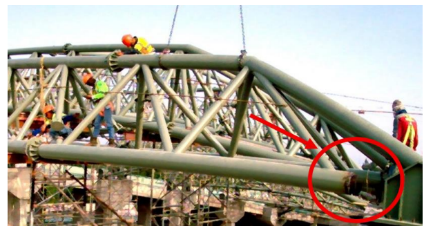
Gambar 7. Pemotongan pipa pada akhir pemasangan rafter
