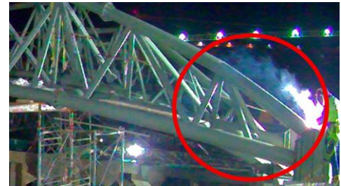
Gambar 15. Pengelasan pada box plate
