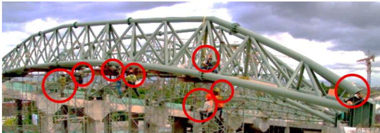
Gambar 14. Pengerahan tenaga kerja untuk reposisi rafter
