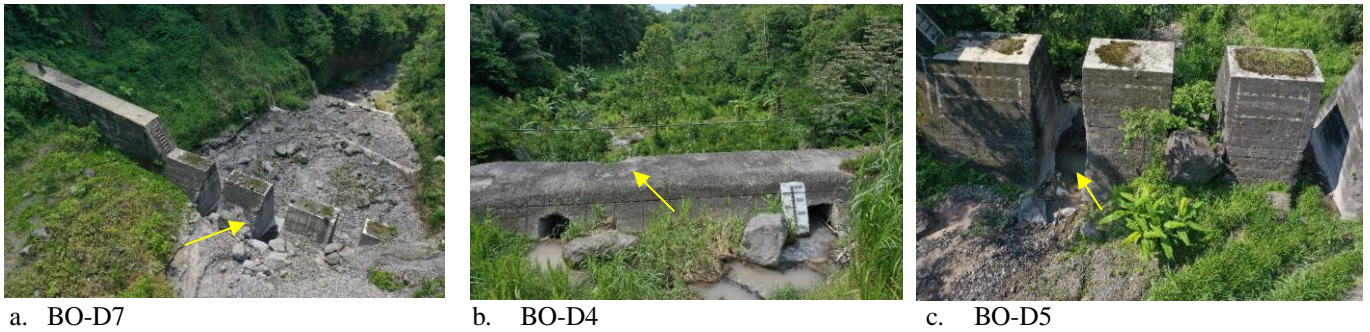
Gambar 3 Abrasi pada Sabodam BO-D7, BO-D4, dan BO-D5
