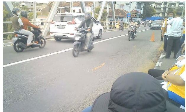
Gambar 10. Pengujian Jembatan Sardjito
