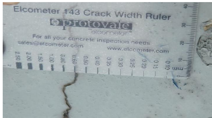
Gambar 2. Sampel Kondisi Jembatan Overpass Ngasem
