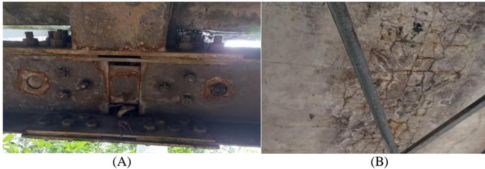
Gambar 3.1 (A) karat pada sambungan baut, (B) *spalling* pada lantai jembatan.
